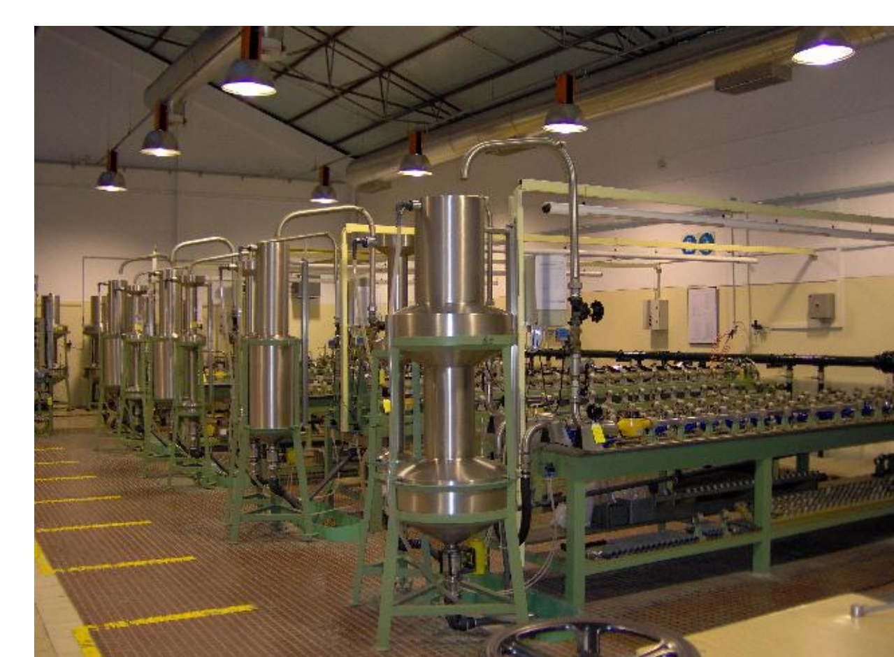
Contadores de água em verificação
